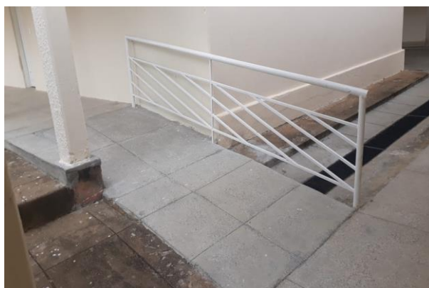
Figura 9: Escola 02 E.M.E.I.E.F Tereza Dutra – rampa 01.
