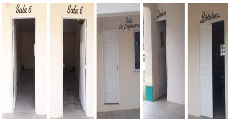
Figura 13: Escola 02 E.M.E.I.E.F Tereza Dutra – vista das portas de acesso.
