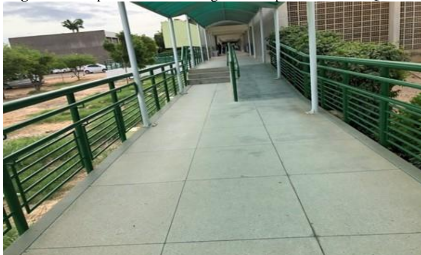
Figura 7. Rampa com corrimão e guarda-corpo no Bloco de Química
