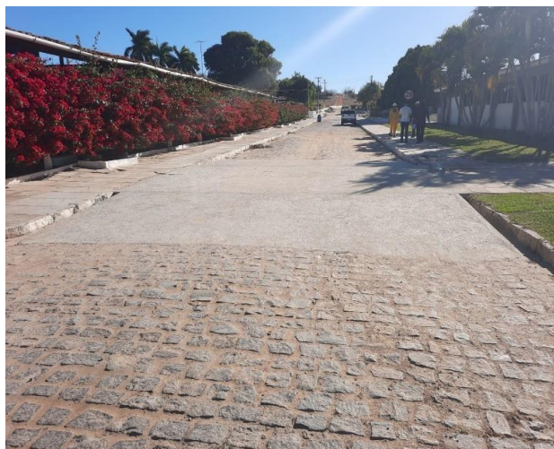
Figura 21. Implantação de passarela elevada em concreto interligando o bloco Centro de Qualificação e Padaria
