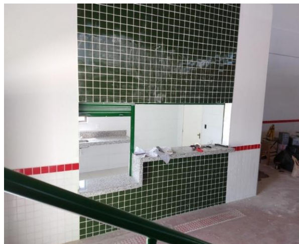
Figura 17. Cantina com balcão de altura acessível
