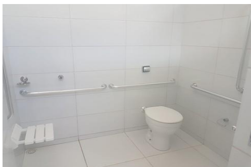
Figura 30. Sanitário acessível com barras de apoio e banco articulado
