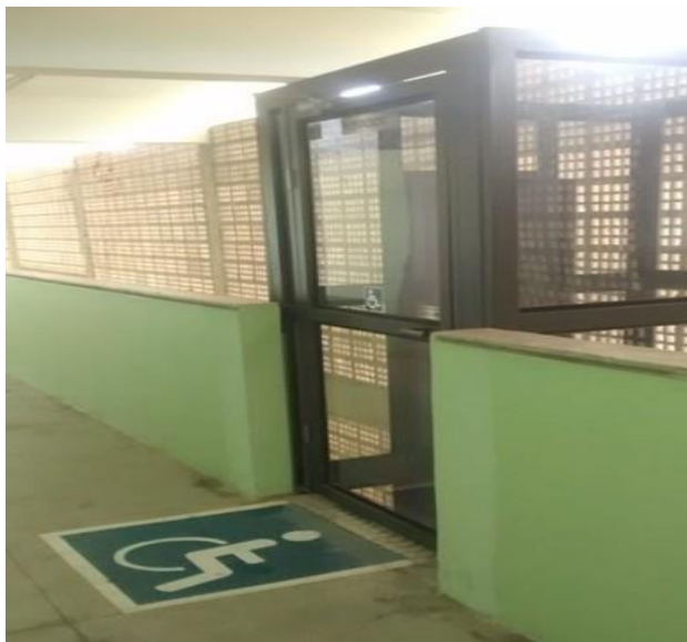
Figura 9. Plataforma elevatória no Bloco Administrativo
