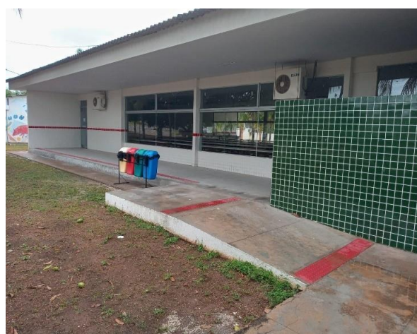
Figura 19. Rampa de acesso com sinalização de piso podotátil no Refeitório
