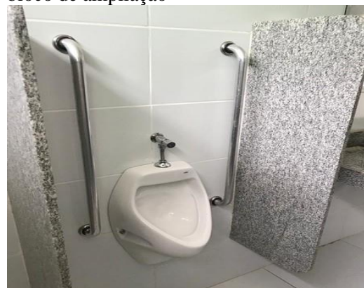
Figura 27. Mictório com barras de apoio no bloco de ampliação
