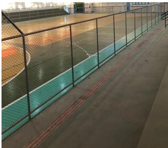
Figura 16. Piso podotátil direcional
