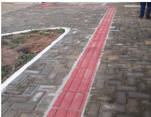
Figura 26. Piso podtátil no prédio existente
