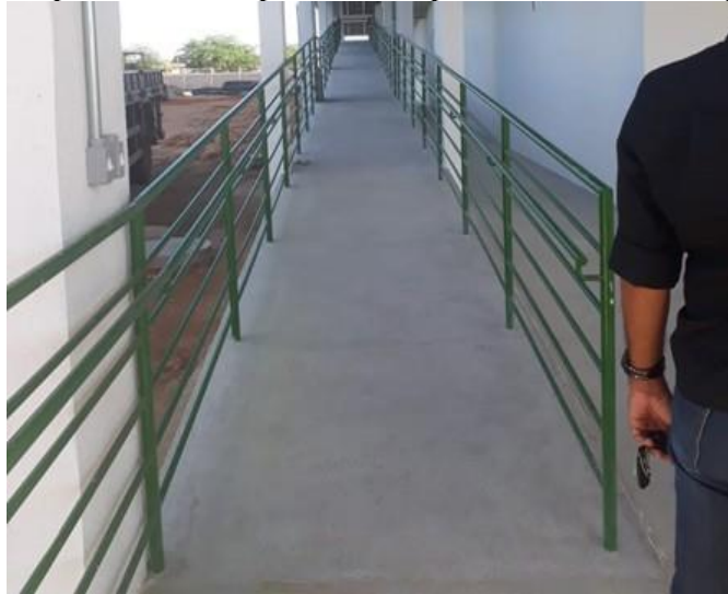
Figura 10. Rampa de acesso ao pavimento superior com corrimão e guarda-corpo
