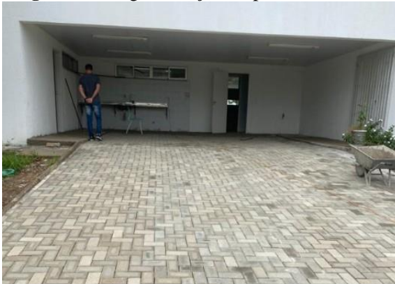
Figura 22. Regularização de piso intertravado
