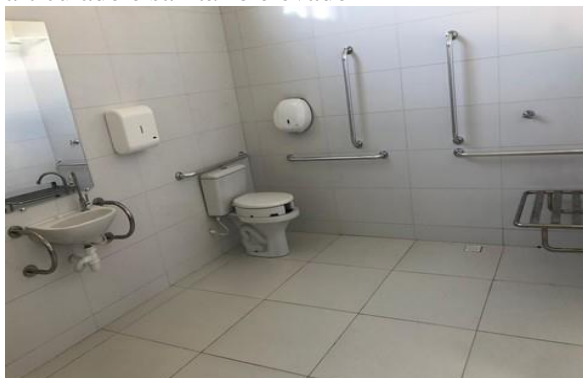
Figura 12. Vestiário com barras de apoio, banco articulado e sanitário elevado
