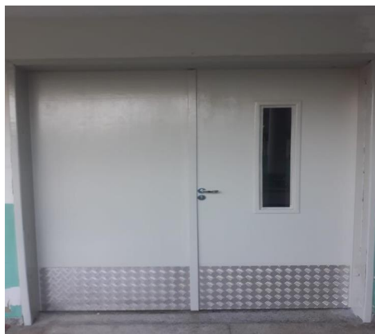
Figura 33. Porta instalada com visor de vidro e chapa de proteção metálica
