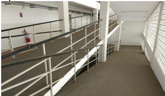
Figura 3. Rampas de acesso a pavimentos superiores com corrimãos
