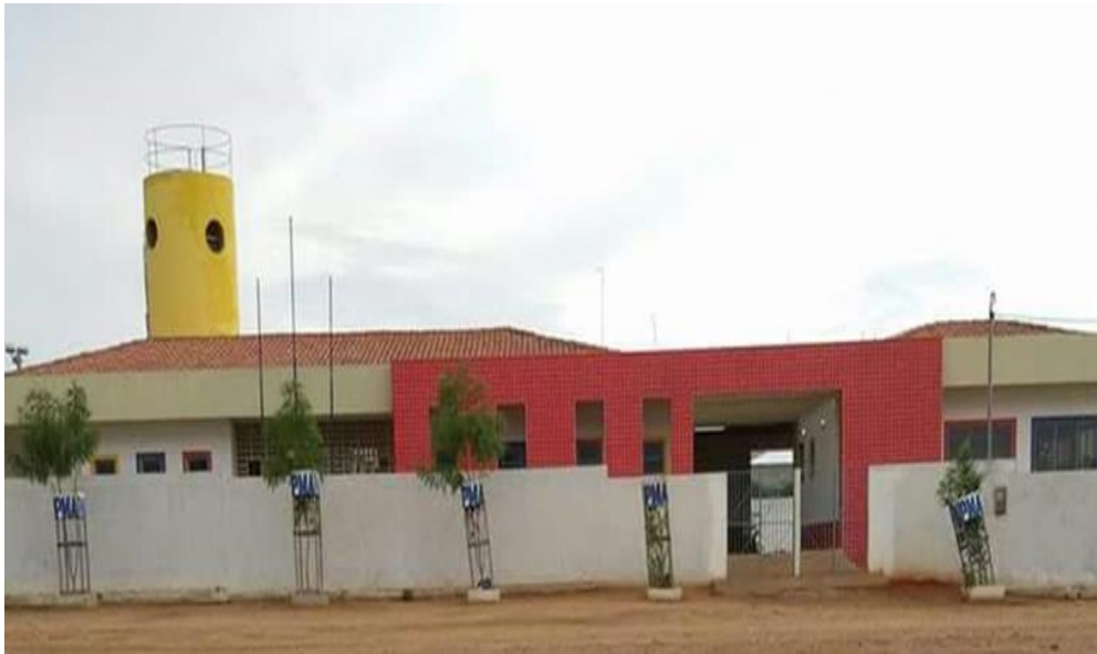
7 Fonte: Foto retirada da internet – Creche- Padrão FNDE- Distrito de Extrema- Afrânio- PE
