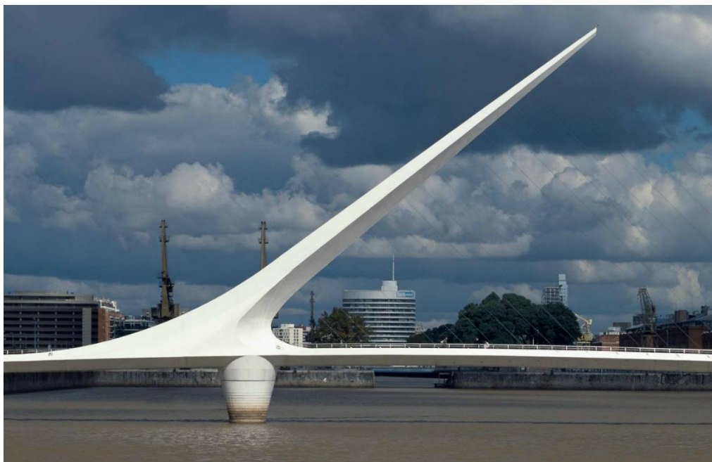
Figura 03: Puente de la Mujer Bridge, Buenos Aires – Argentina
