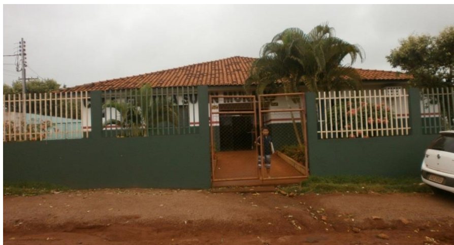
FIGURA 2: ENTRADA PRINCIPAL DO CME GENTILA SUSIN MURARO
